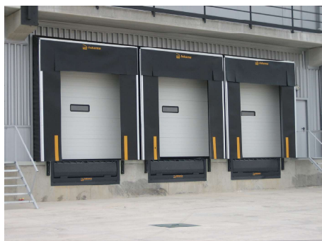
W każdym obiekcie, w którym odbywa się załadunek i rozładunek, niezbędne są rękawy chowane.
